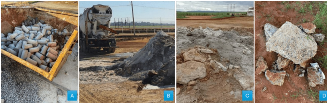
Figura 1. Resíduos da Construção Civil (RCC) coletados na obra. A. Resíduos de corpos de prova; B. RCC comum, classe A; C. Material descartado após a concretagem; D. Concreto usinado, restante da concretagem. Fonte: Santos et al. (2025).
